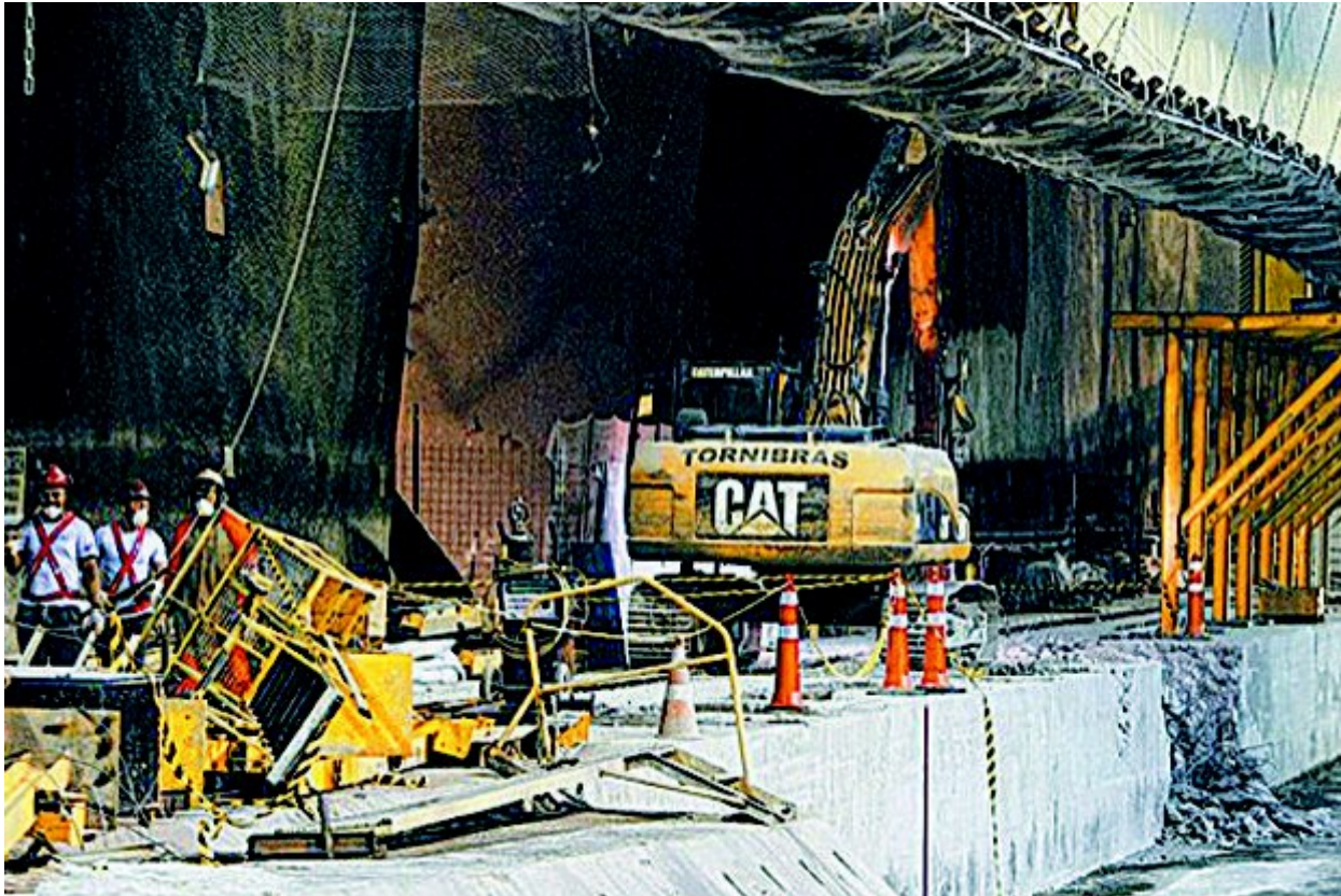
Obra da Linha 4 do Metrô: Estação da Gávea não ficará pronta até a Olimpíada por mudança no projeto
